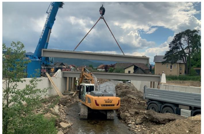
**Kobenz:** Fünf T-förmige Halbfertigteile, jeweils 16 Tonnen schwer.
