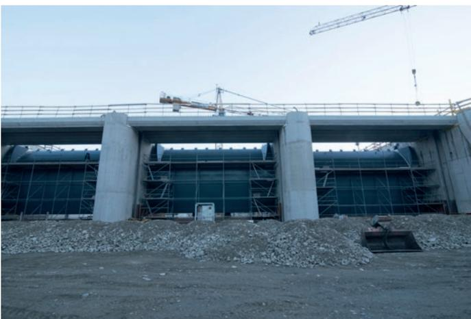
**Murkraftwerk Graz:** Drei knapp 20 Meter lange Träger zu je 33 Tonnen.
