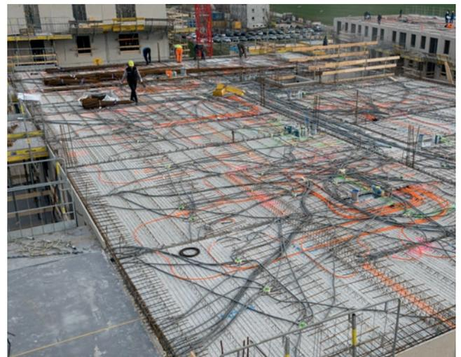
**Klimadecke im Großesatz:** Beim Bauprojekt „Jonas am Feld“ am Badeteich Hirschstetten in Wien wurden am MABA-Standort Gerasdorf werksseitig bereits rund 80.000 Laufmeter Verrohrung in die als Halbfertigteile ausgeführten bauteilaktivierten Deckenelemente eingebaut.
